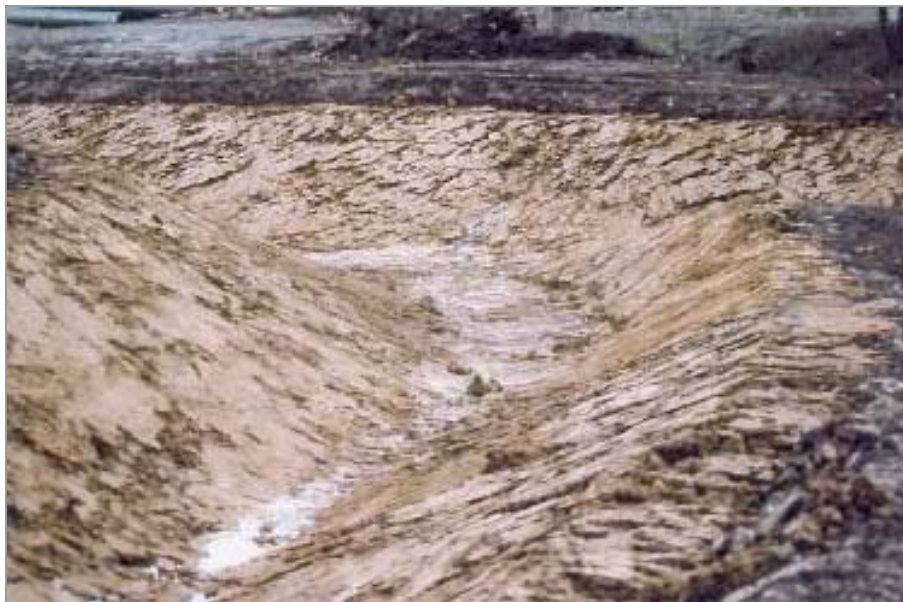
Lehmabdichtung im Bau
